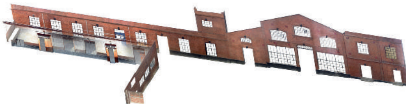
Ortoimágenes de la fachada principal
