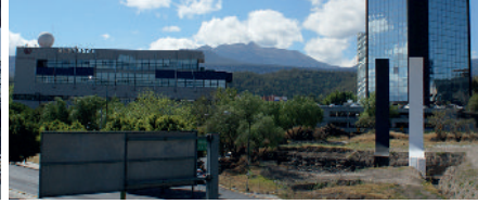
Trébol vial de Periférico Sur y Av. Insurgentes Sur
