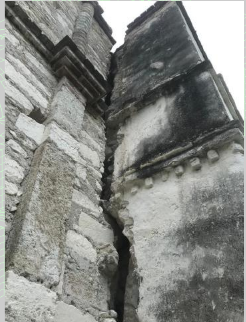
Desprendimiento contrafuerte
