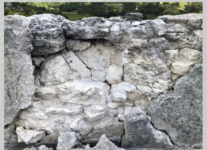
Material en muro testero
