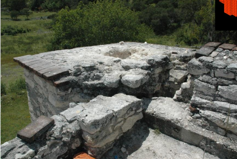
Detalle superior contrafuerte
