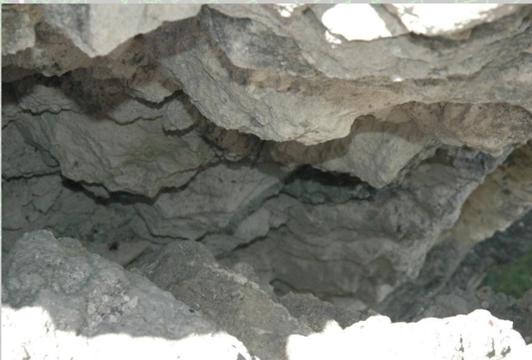
Material en contrafuerte
