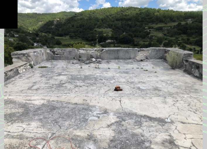
Losa y muro testero
