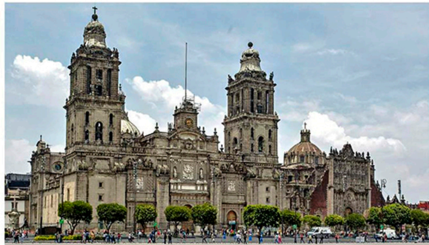
■ El arquitecto y restaurador lideró un equipo de expertos que, entre 1989 y el año 2000, lograron rescatar del hundimiento a la Catedral Metropolitana.
