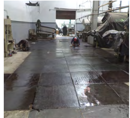
Trabajos de restauración en pisos en el área de amonedación de la Casa de Moneda
