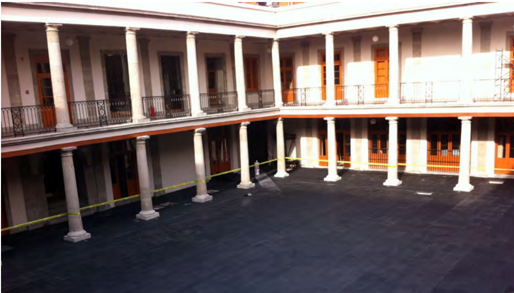
Patio central al concluir los trabajos de intervención
