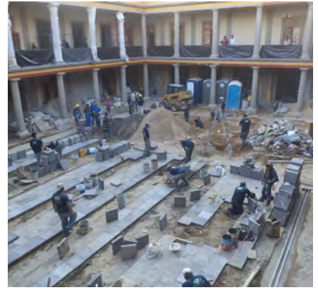
Colocación de recinto en el patio central de la Casa de Moneda
