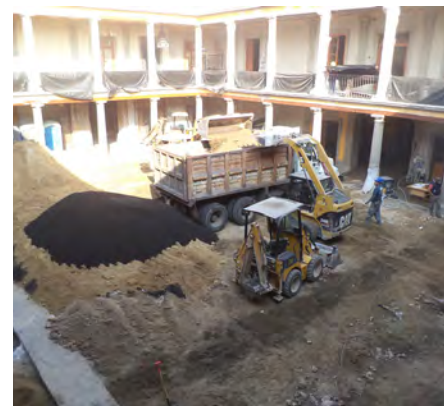
Inicio de los trabajos en el patio central de la Casa de Moneda
