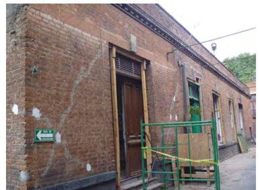
Inicio de trabajos de restauración en la antigua fábrica de chocolates “La Cubana”
