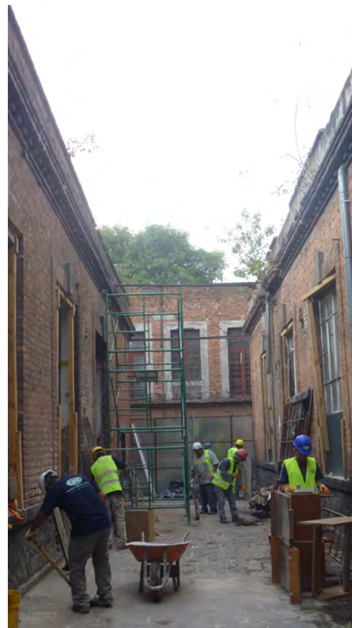
Obras en la antigua fábrica de chocolates “La Cubana”
