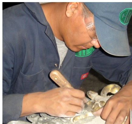
Trabajos de restauración en el Palacio Federal de Chihuahua
