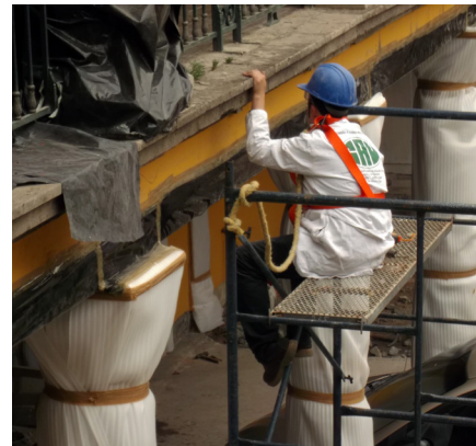
Trabajos de restauración en Casa de Moneda
