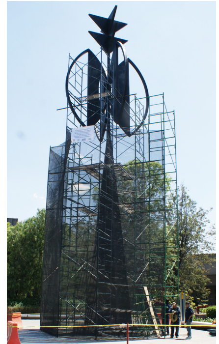
Trabajos de restauración en la escultura La Espiga, Ciudad Universitaria, México D.F.
