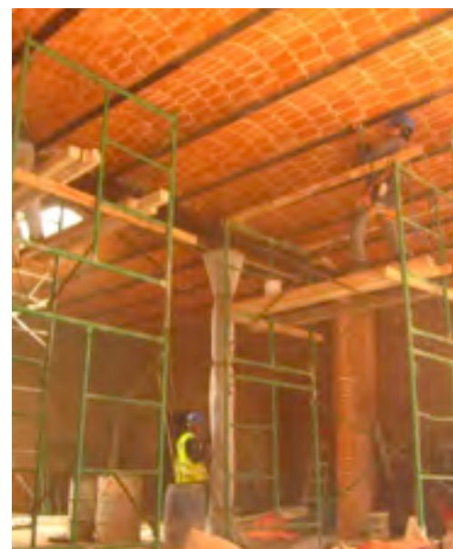
Bóvedas catalanas. La imagen de la izquierda muestra el acabado final de los trabajos realizados en las bóvedas catalanas: la limpieza y reintegración de tabiques; y el acabado final en los patines de las vigas I: limpieza y pasivado del metal. Las dos imágenes de arriba representan el antes y durante de los trabajos de intervención en la Galera central de la Crujía Norte
