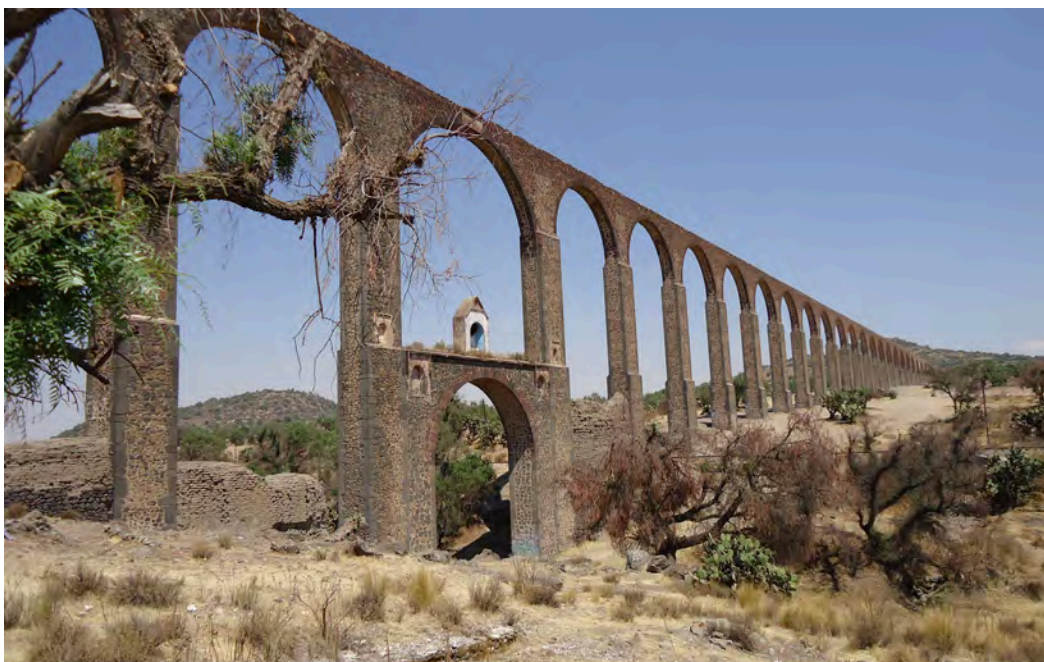
Acueducto del Padre Tembleque, Santiago Tepeyahualco, Estado de Hidalgo
