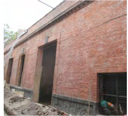
Tomada después de los trabajos de limpiezas e integración de pátina al inmueble
