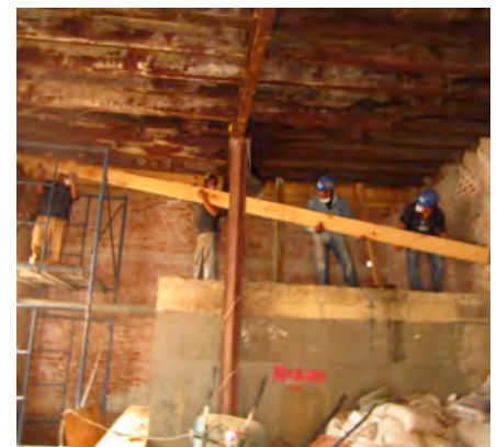
Trabajos de intervención en la Crujía Norte
